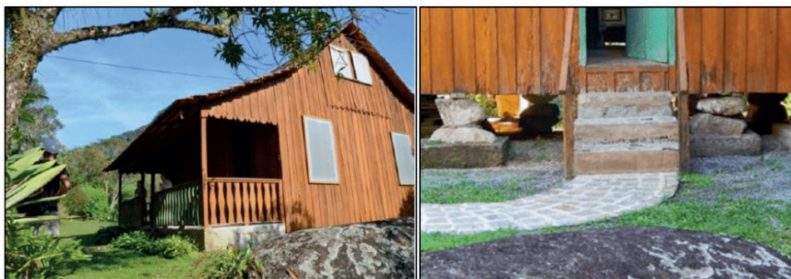
Figura 1- A direita, casa histórica da família Gervásio e Bauer; a esq., a sustentação da casa por pedras irregulares.
